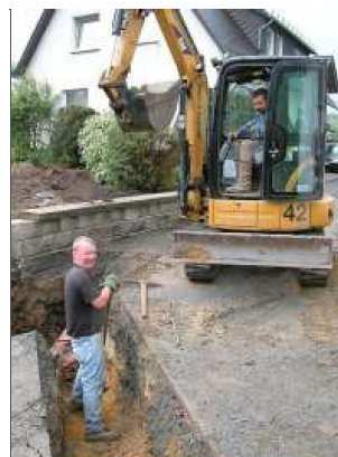
Die Arbeiten im Energiedorf laufen schon: Derzeit werden neue Leitungen verlegt.
