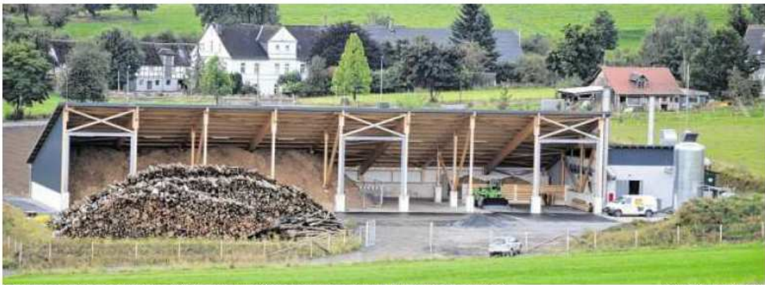
Bio-Energieanlage in Wallen mit Blockheizkraftwerk und Lagerhalle für die Hackschnitzel
