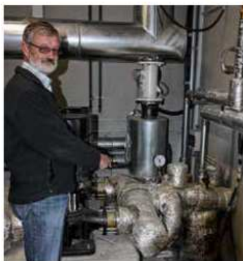
Über in der Zentrale noch 130 Millimeter dicke Rohre wird von hier aus das Dorf im 5,5 Kilometer langen, bald verstellten Netz versorgt.
