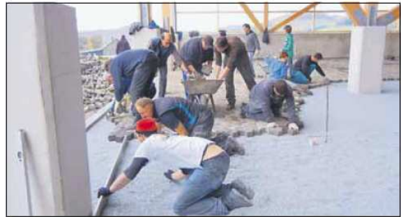
Das Engagement der Dorfbewohner ist groß: Die Pflasterarbeiten wurden von vielen freiwilligen Helfern durchgeführt.
