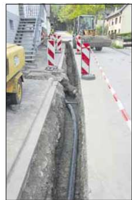
Insgesamt 5 km Wärmeleitungen wurden im gesamten Ort verlegt, um die Haushalte an das Nahwärmenetz anzuschließen.
